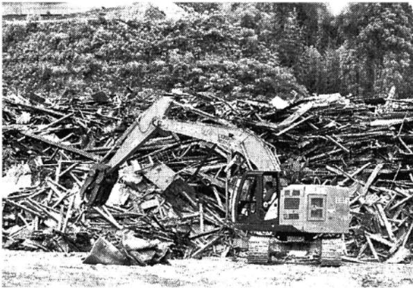
被災地では家屋解体が進められている
