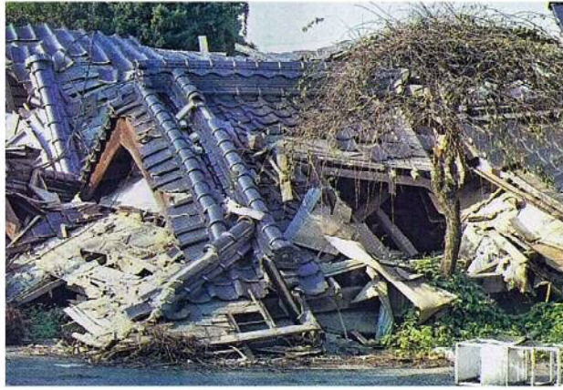
被災家屋の解体・撤去が急がれている
