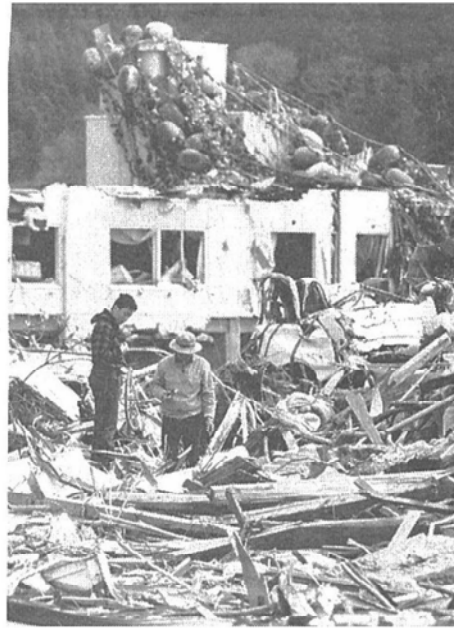
いまだに撤去されず、散乱したままのがれき 30日午前、宮城県南三陸町で
