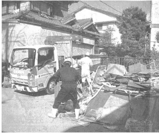
紀宝町での災害廃棄物の撤去作業
