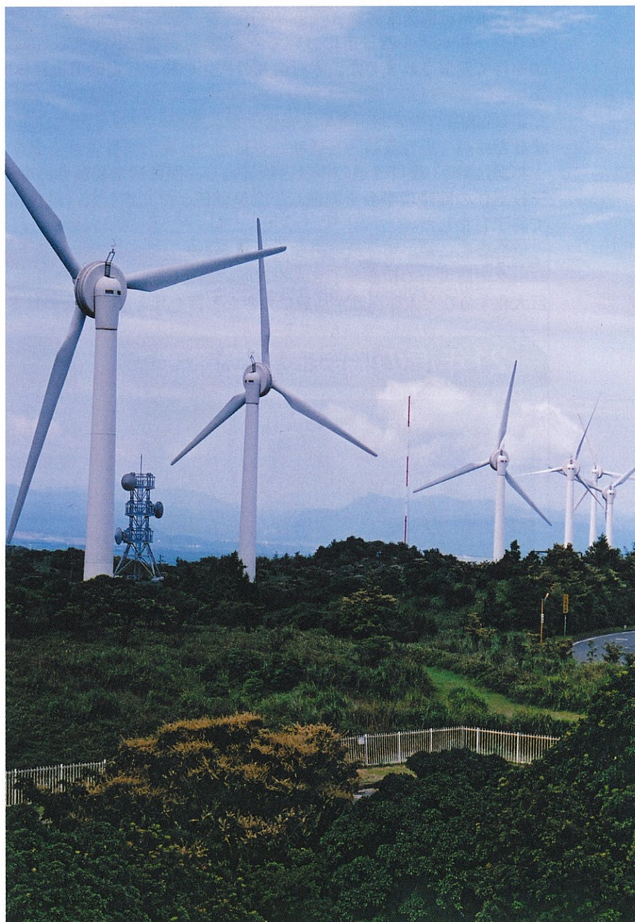
(青山高原にある久居榊原風力発電施設)
