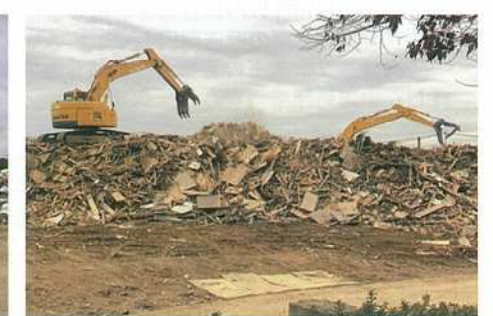
長野市の作業現場
