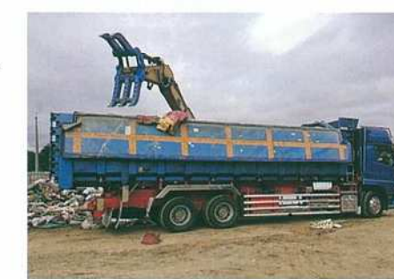
千曲市の作業現場
