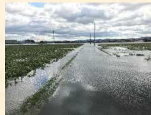
農地の浸水被害（平成29年10月 松阪市）
