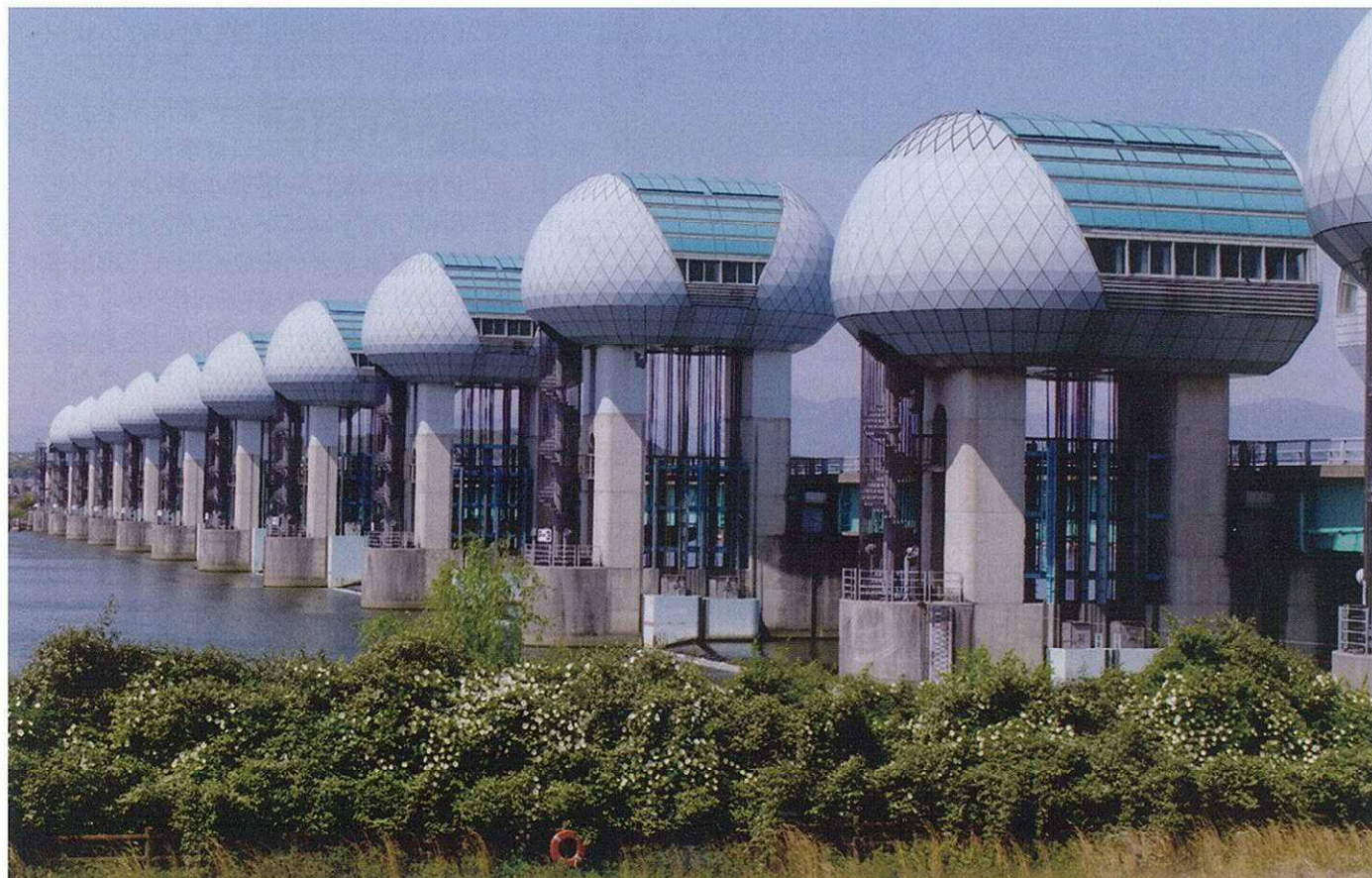
運用して約20年経った長良川河口堰（桑名市）
